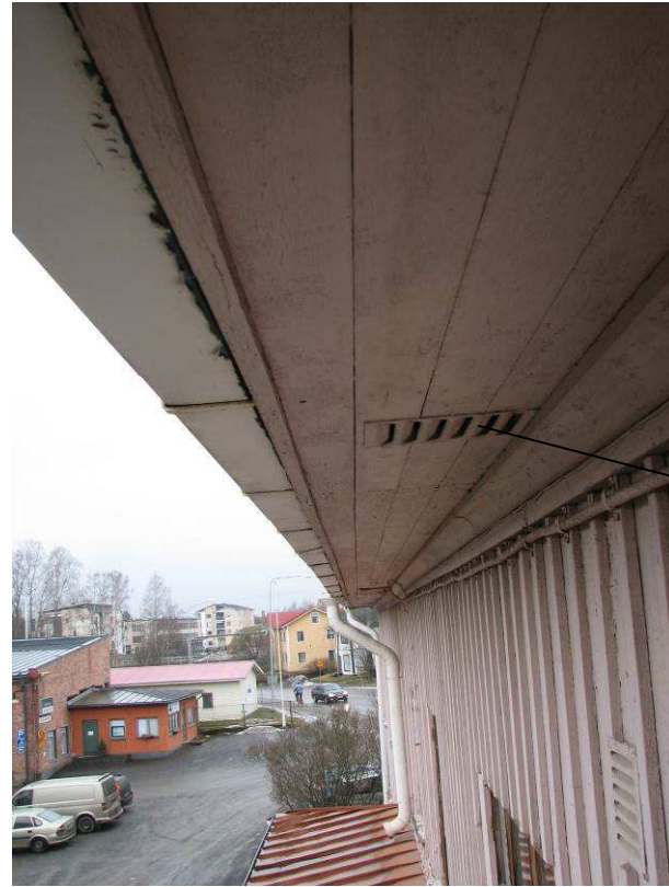
Kuva 47. Räystäs ja välikaton tuuletus. Räystäs on umpilaudoitettu, välikaton tuuletus toimii raitisventtiilien kautta jotka esiintyvät kuvissa, ~3 kpl/pitkäsivu, 2kpl/pääty, mitat 220x300mm.
