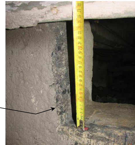
Kuva 48. Ryömintätilan tuuletusaukot sokkelissa Koko~240x250mm, ja 3-4kpl/pitkäsivu
