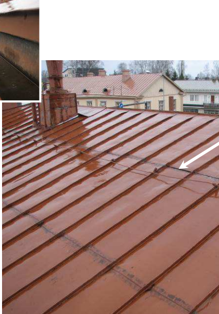
Kuva 41. Epätiivis peltikattosauma
