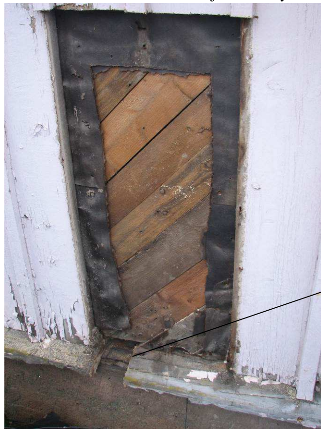
Kuva 49. Julkisivurakenne. Tervapaperi julkisivulaudoituksen ja viistolaudoituksen välissä. Tiheässä viistolaudoituksessa esiintyy näkyviä mikrobivaurioita. Julkisivupaneeli on lomalaudoitus. Alalauta ~180x25 + rimat 40x25 mm. Julkisivupaneelin takana ei ole tuuletusväliä.
