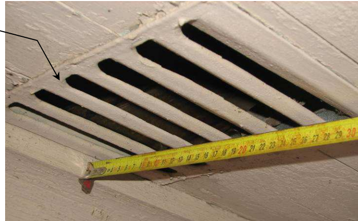
Kuva 47. Räystäs ja välikaton tuuletus. Räystäs on umpilaudoitettu, välikaton tuuletus toimii raitisventtiilien kautta jotka esiintyvät kuvissa, ~3 kpl/pitkäsivu, 2kpl/pääty, mitat 220x300mm.
