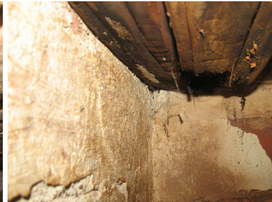
Kuva 5a-b. Kellarinkatto on laudoitettu. Laudoituksen pinnassa esiintyy mikrobikasvustoa ja paikoittain pitkälle edenneitä lahovaurioita.
