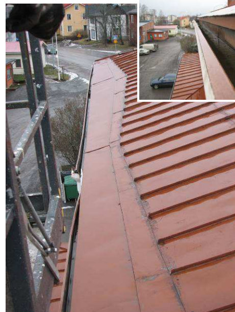
Kuva 40. Kattorännijärjestelmä on nykyään ulkopuolella ripustettuja katto rännejä
