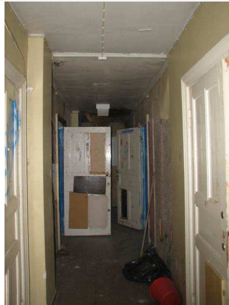
Kuva 31. Käytävä, Vierellä väliseinä joka on eristetty toja-eristelevyllä
