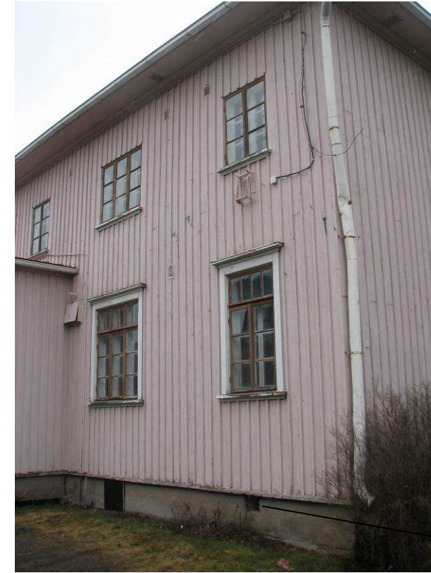
Kuva 48. Ryömintätilan tuuletusaukot sokkelissa Koko~240x250mm, ja 3-4kpl/pitkäsivu
