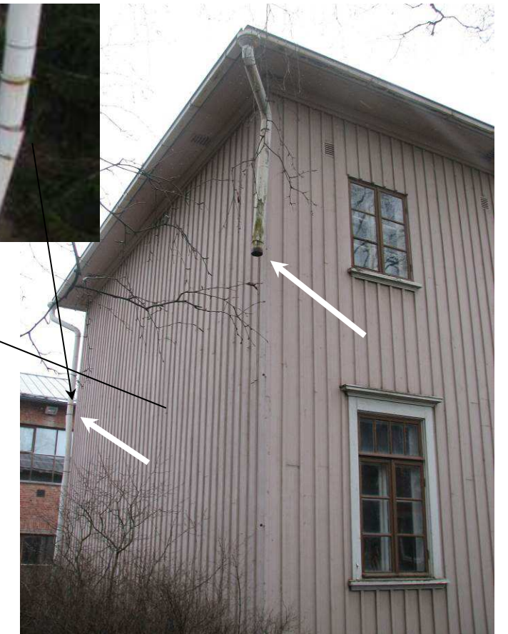
Kuva 45. Päädyn julkisivu. Sadeveden syöksyputkesta puuttuu alaosa. Toinen syöksyputki on epätiivis liitoskohdassa. Sadevesi voi rasittaa julkisivua.
