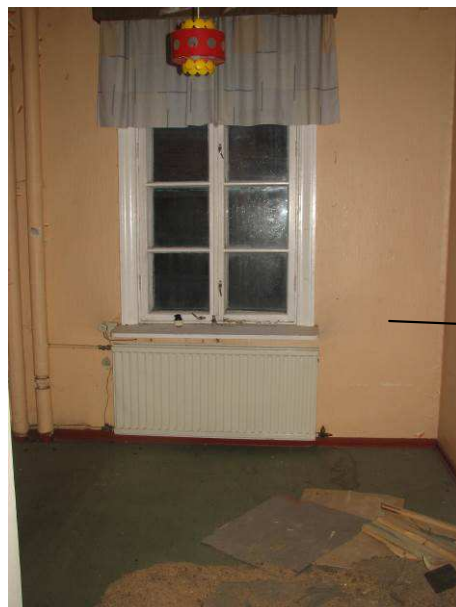
Kuva 17. Lepohuone. Linoleumimatto lattialla Maalattu huokoinen puukuitulevyä seinällä.
