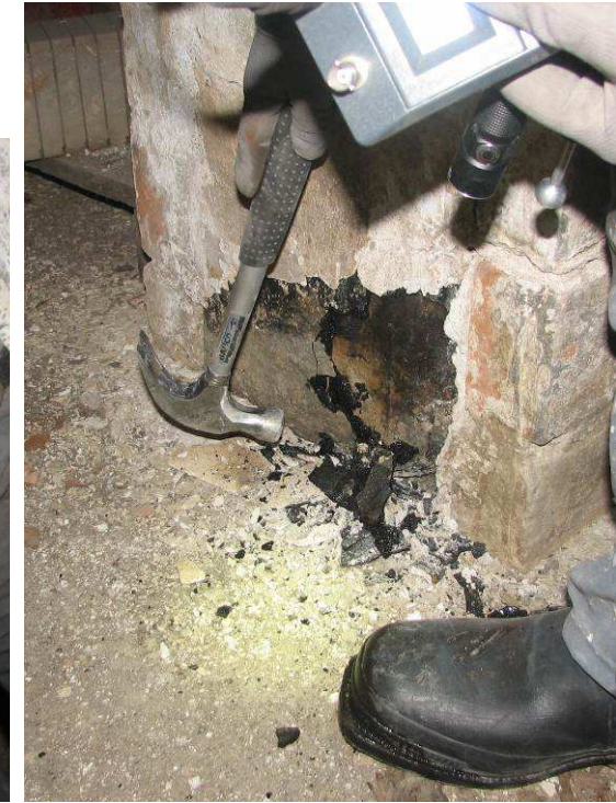
Kuva 4. Lattiavalun ja seinän tiilimuurauksen takana on pikieriste/vesieriste. Katso sivu 6 ja PAH-näyte 5.
