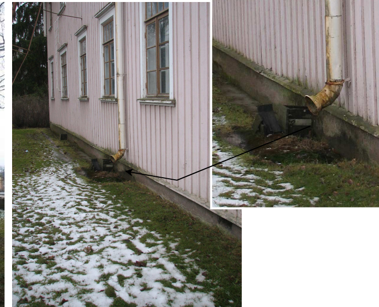
Kuva 44. Julkisivukuva pitkältä sivulta joka on tien puolella. Maapinta kiinteistön vierellä viettää taloon päin tai on suora. Sadevesijärjestelmä toimii periaatteella maahan imeytyminen
