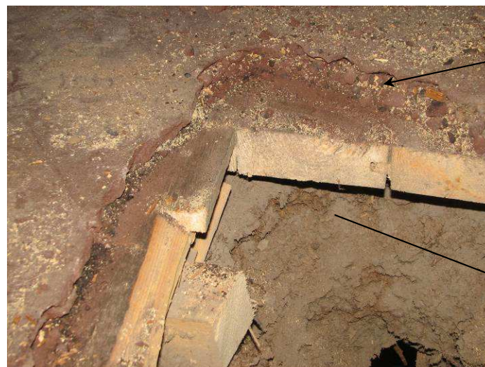
Kuva 30. Lattiarakenne salissa. Massalattia ja sen alla pikikerros vanhan lankkulattian päällä.
