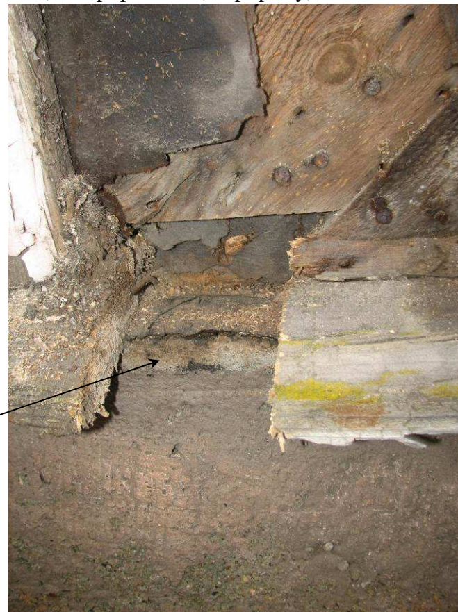
Kuva 49. Julkisivurakenne. Tervapaperi julkisivulaudoituksen ja viistolaudoituksen välissä. Tiheässä viistolaudoituksessa esiintyy näkyviä mikrobivaurioita. Julkisivupaneeli on lomalaudoitus. Alalauta ~180x25 + rimat 40x25 mm. Julkisivupaneelin takana ei ole tuuletusväliä.
