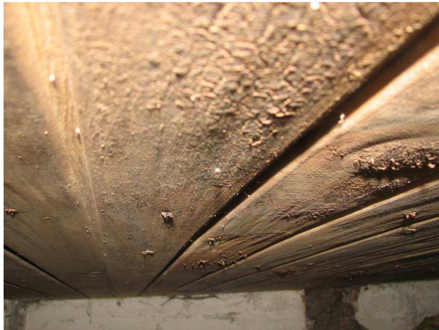
Kuva 5a-b. Kellarinkatto on laudoitettu. Laudoituksen pinnassa esiintyy mikrobikasvustoa ja paikoittain pitkälle edenneitä lahovaurioita.
