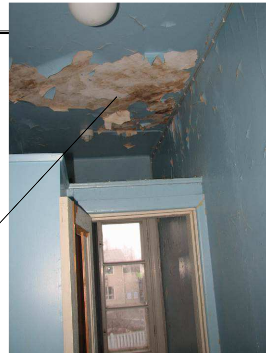
Kuva 32. Pesutilan katto, vuotovahinko katolta esiintyy sisäkatossa
