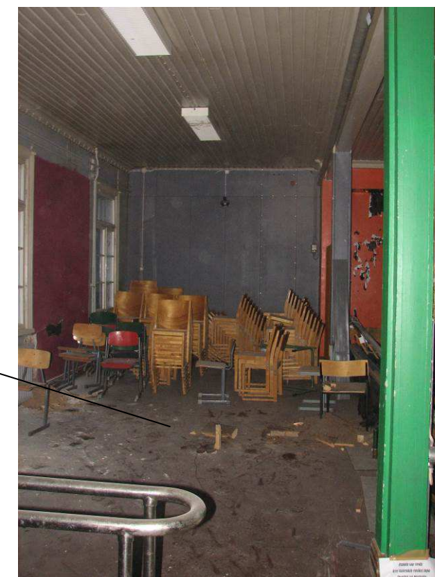
Kuva 23. Sali Seinät rapattu sisäpuolella. Lattia massalattia + pikikerros lankkulattian päällä.
