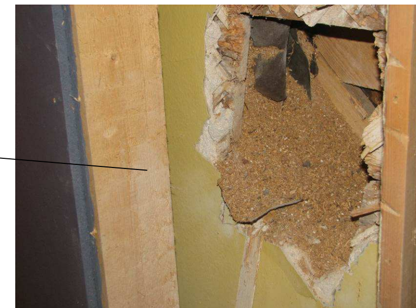
Kuva 29. Ulkoseinärakenne +lisäkoolaus
