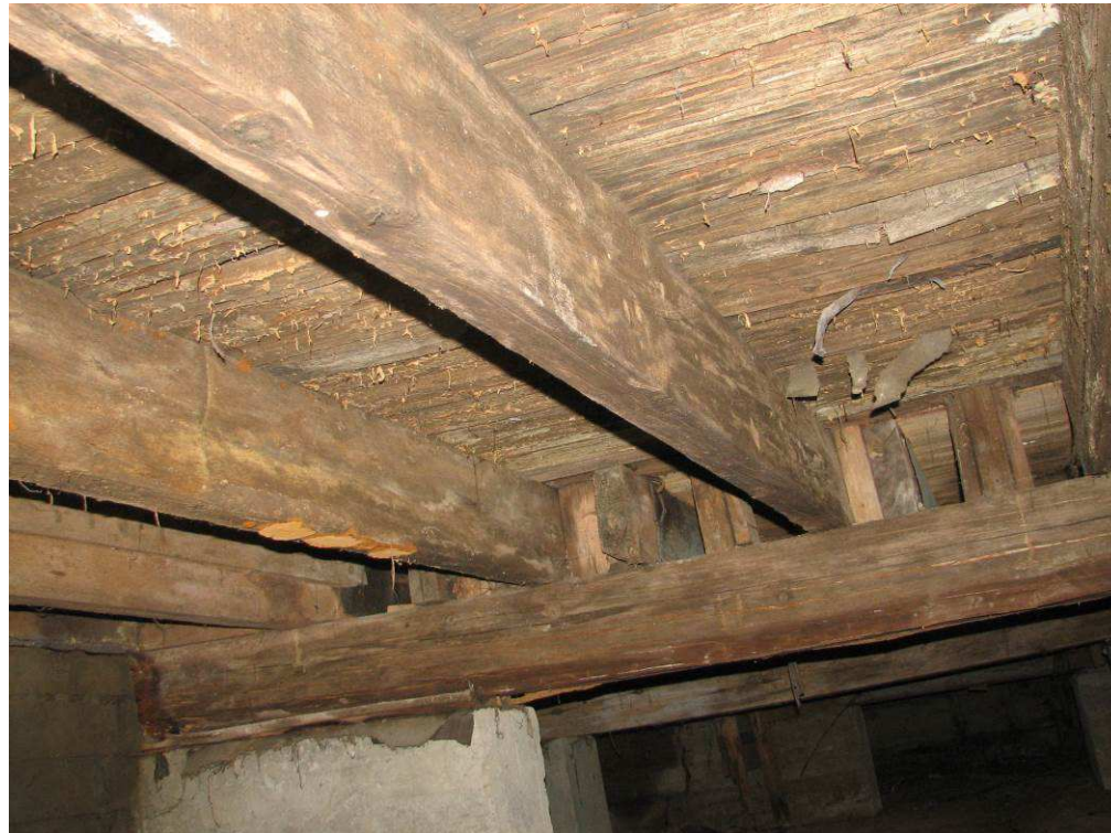
Kuva 11-13. Yleisnäkömä rossipohjalaudoituksesta. Näkyvää mikrobikasvustoa lautojen pinnoissa ja lahovaurioita
