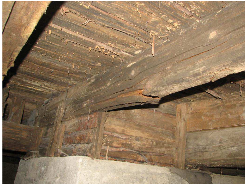
Kuva 11-13. Yleisnäkömä rossipohjalaudoituksesta. Näkyvää mikrobikasvustoa lautojen pinnoissa ja lahovaurioita
