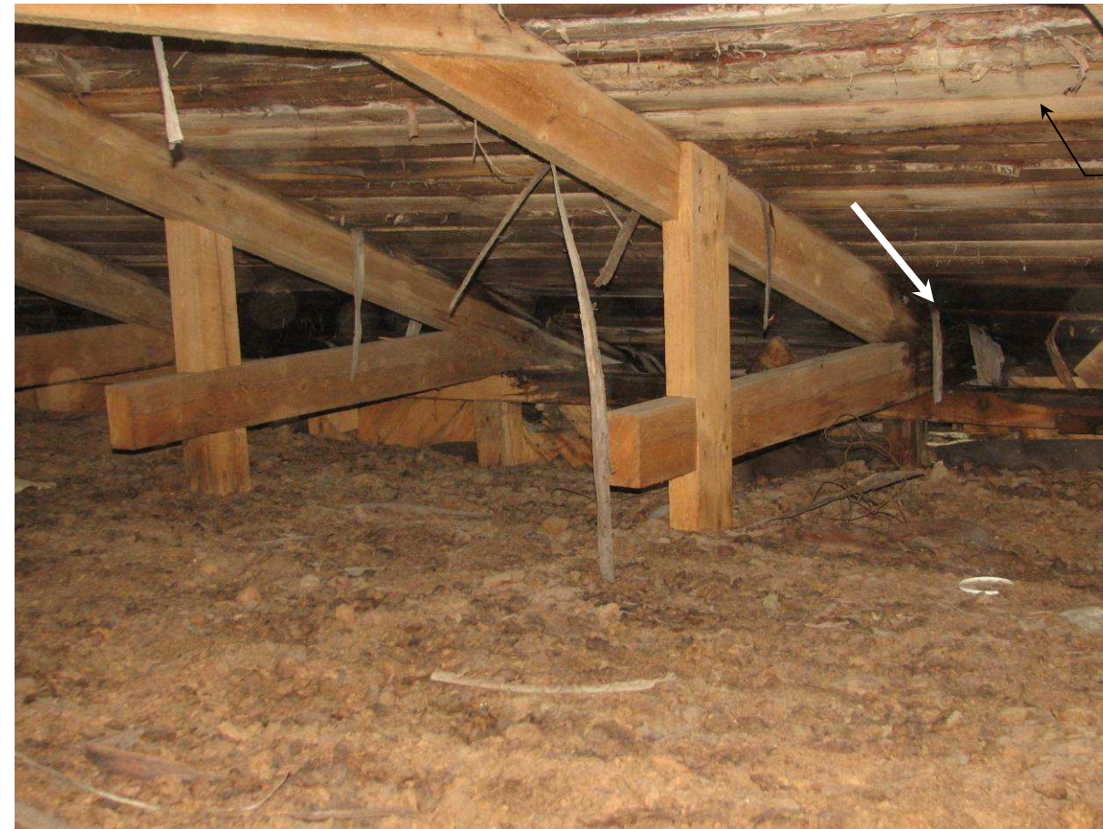
Kuva 38-39. Yleisnäkymä välikattotilasta, kattoruoteissa esiintyy mikrobivaurioita ja räystäskohdalla kattoruoteet ovat tummia/lahonneita. Välikattotilan tuuletus on alhainen ja tilassa on vaurioituneen puumateriaalin haju. Välikattoeriste on pääasiassa turvetta mutta paikoittain eristeenä esiintyy myös sahanpurua. Konesaumattu peltikatto on asennettu kattoruoteen/tiheälaudoituksen päälle, aluskatetta ei esiinny.
