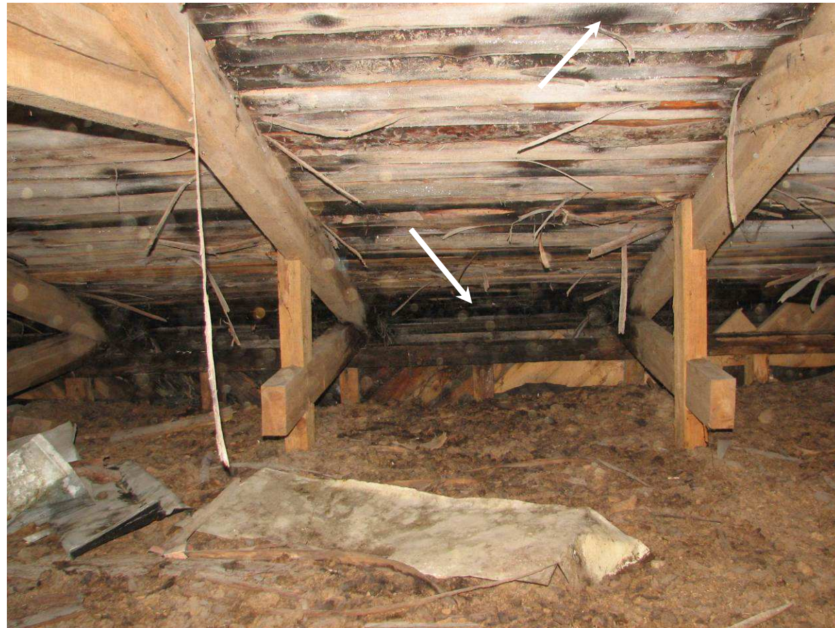
Kuva 38-39. Yleisnäkymä välikattotilasta, kattoruoteissa esiintyy mikrobivaurioita ja räystäskohdalla kattoruoteet ovat tummia/lahonneita. Välikattotilan tuuletus on alhainen ja tilassa on vaurioituneen puumateriaalin haju. Välikattoeriste on pääasiassa turvetta mutta paikoittain eristeenä esiintyy myös sahanpurua. Konesaumattu peltikatto on asennettu kattoruoteen/tiheälaudoituksen päälle, aluskatetta ei esiinny.
