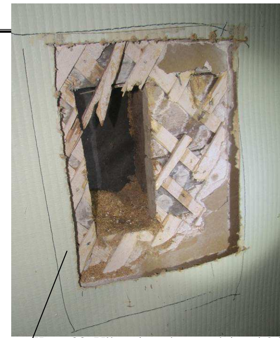
Kuva 33. Ulkoseinä rakenne yleisesti 2.kerroksessa. Pinkopahvi/rappi/tiheälaudoitus/sahanpuru/tervapaperi/Tiheälaudoitus/julkisivupaneeli.
