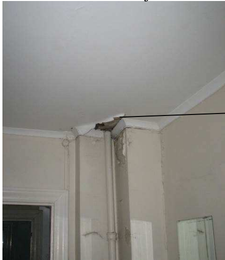
Kuva 37. Kattovuotoalue sisäkatossa, vuotovesi valunut lattiaan asti, vauriojälkiä näkyvissä.
