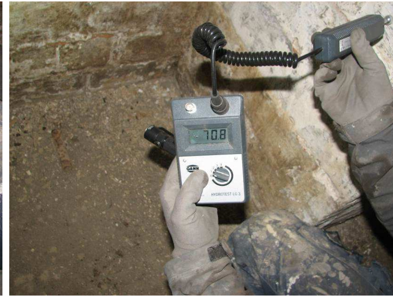
Kuva 3. Pinta-arvot seinän keskiosalta osoittaa kohonneita arvoja (~70/200)
