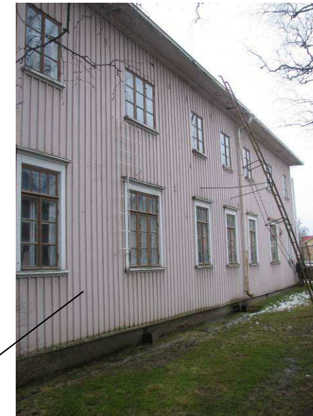
Kuva 44. Julkisivukuva pitkältä sivulta joka on tien puolella. Maapinta kiinteistön vierellä viettää taloon päin tai on suora. Sadevesijärjestelmä toimii periaatteella maahan imeytyminen
